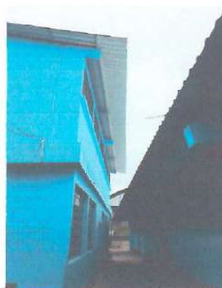
Foto 2: Canales y bajada de agua pluvial.
